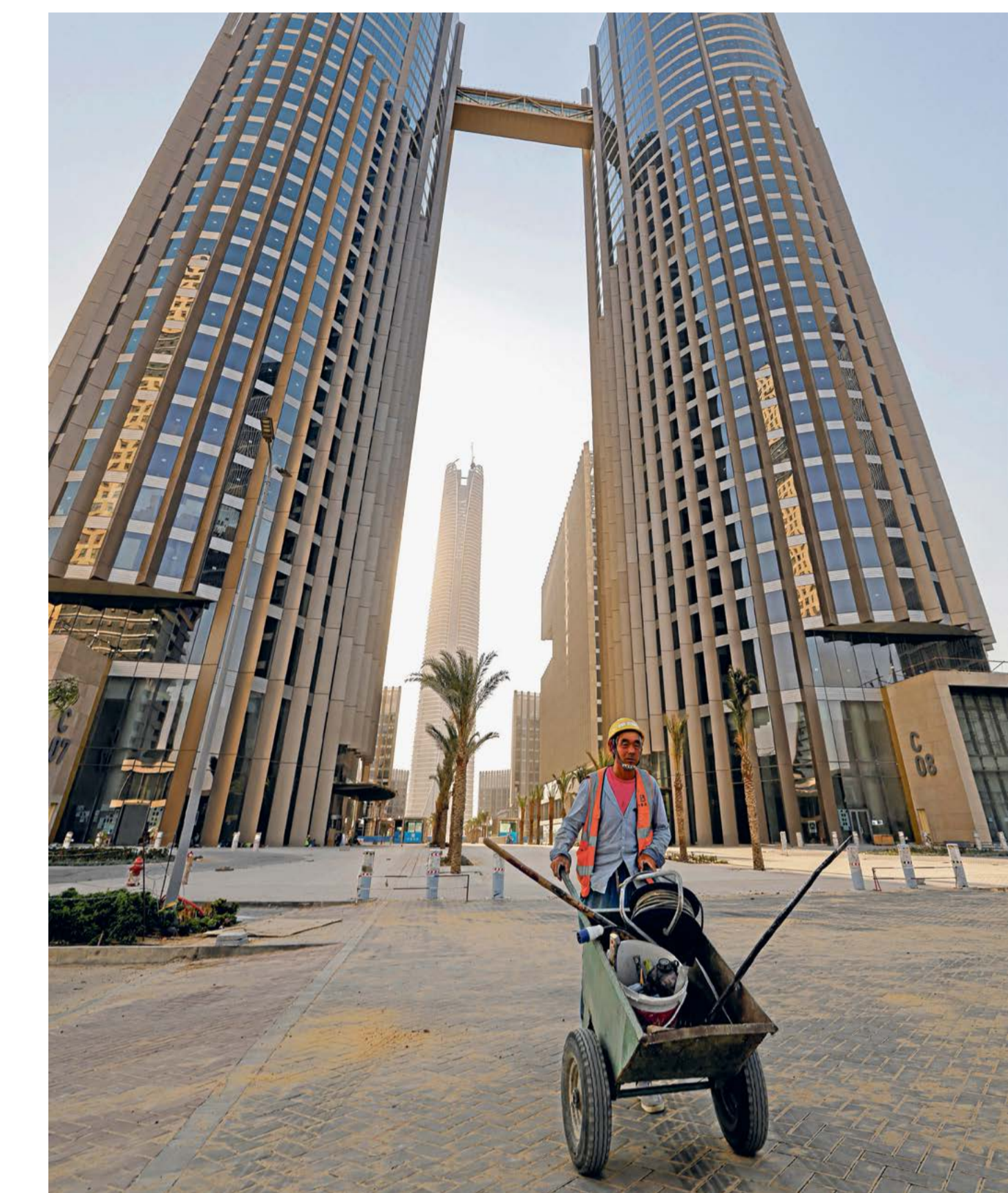
Ein chinesischer Arbeiter auf der Baustelle des Geschäfts- und Finanzviertels in der Neuen Verwaltungshauptstadt, östlich von Kairo.
